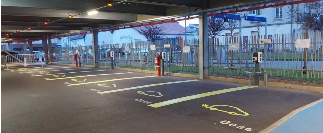
Bornes de recharge au sein du parking Gare Structure (P1)
