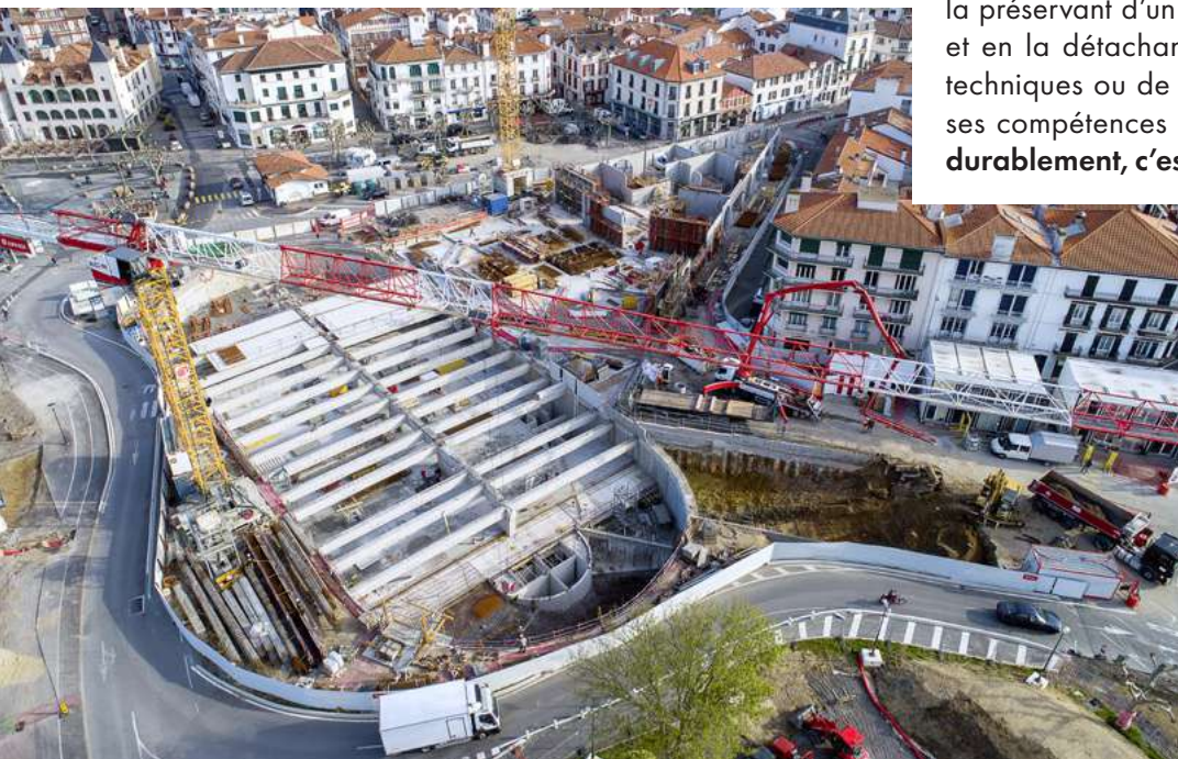
Construction du parking du port à Saint-Jean-de-Luz.
